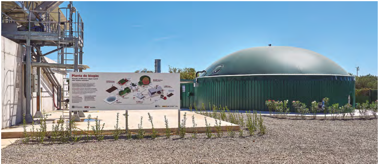
Planta de biogás del IRTA Mas Bové. Fuente: IRTA.
