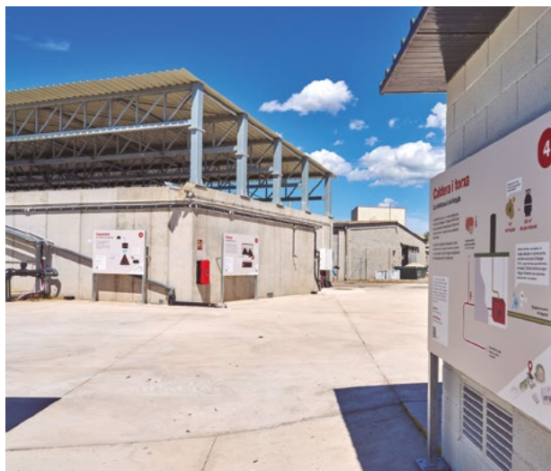
Instal·lacions de la planta de biogàs de l'IRTA Mas Bové. Font: IRTA.
