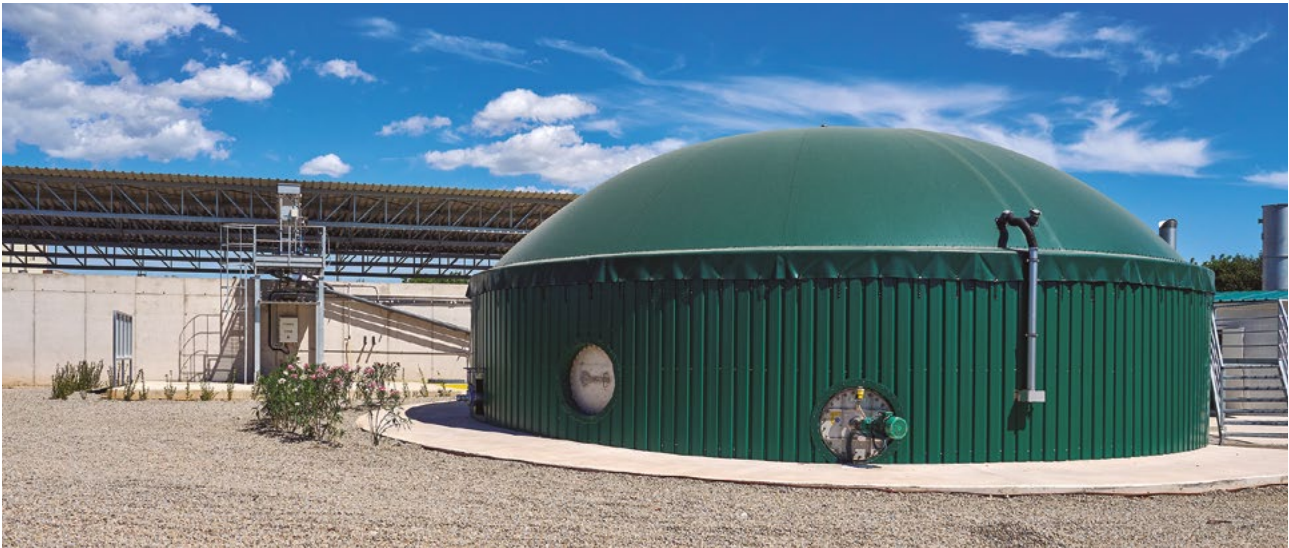
Digestor anaerobi, separador i ferner de la planta de biogàs de l'IRTA Mas Bové. Font: IRTA.
