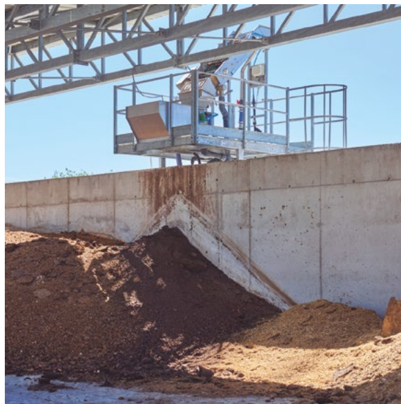
Separador i fomer de la planta de biogàs de l'IRTA Mas Bové. Font: IRTA.
